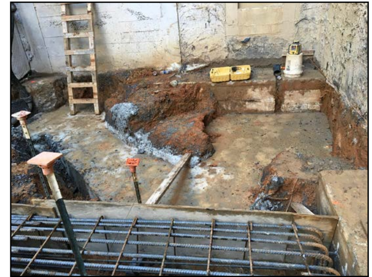
Grade Beam Foundation Pour #1
